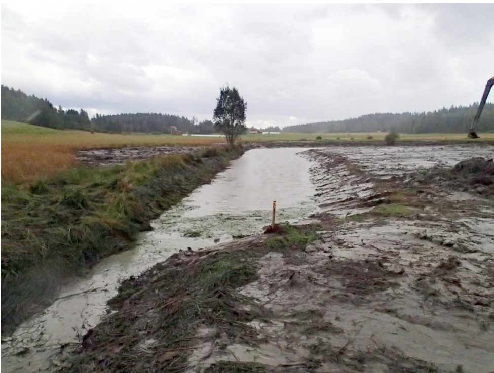
Pitkäniitun kosteikko – paalu 1:n jälkeen
