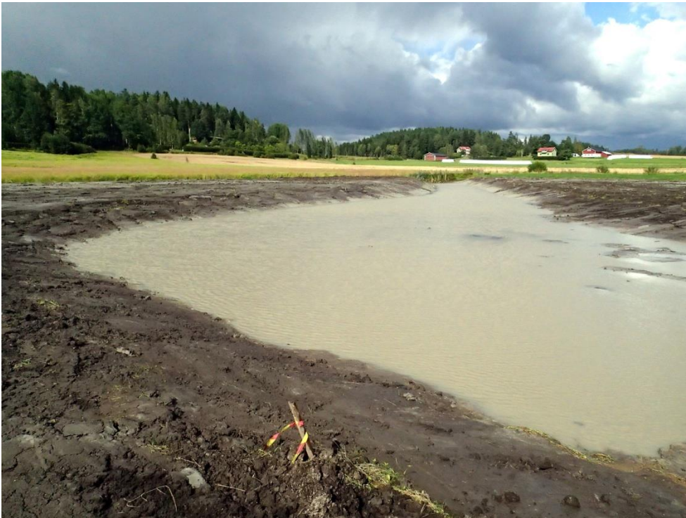
Pitkäniitun kosteikko: Pohjoispää
